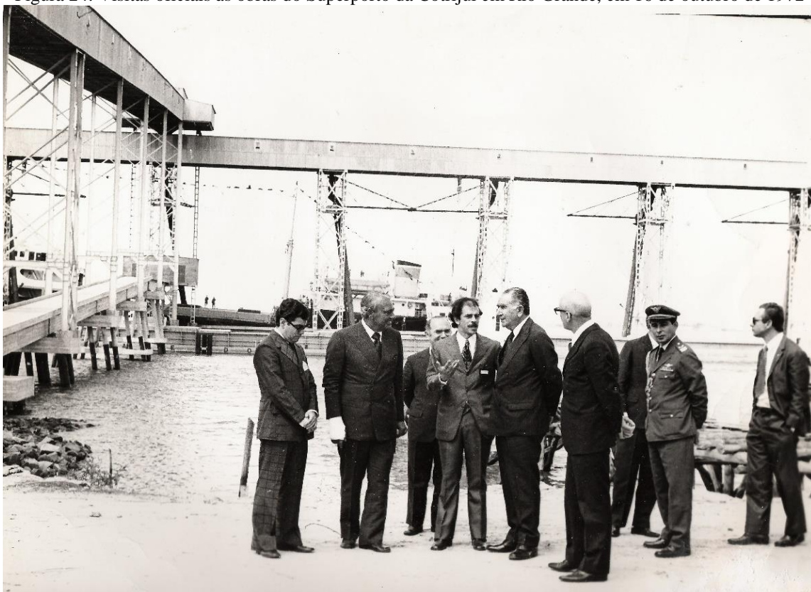
Figura 24: Visitas oficiais às obras do Superporto da Cotrijui em Rio Grande, em 16 de outubro de 1972
