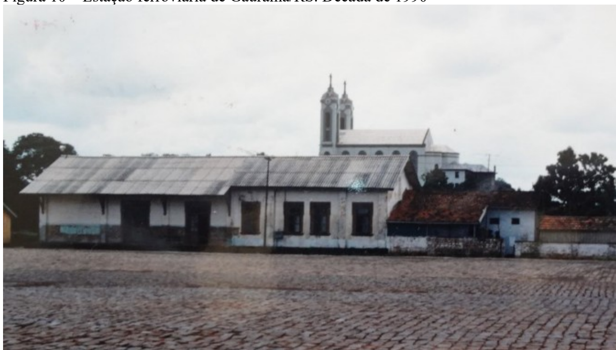
Figura 10 – Estação ferroviária de Gaurama/RS. Década de 1990
